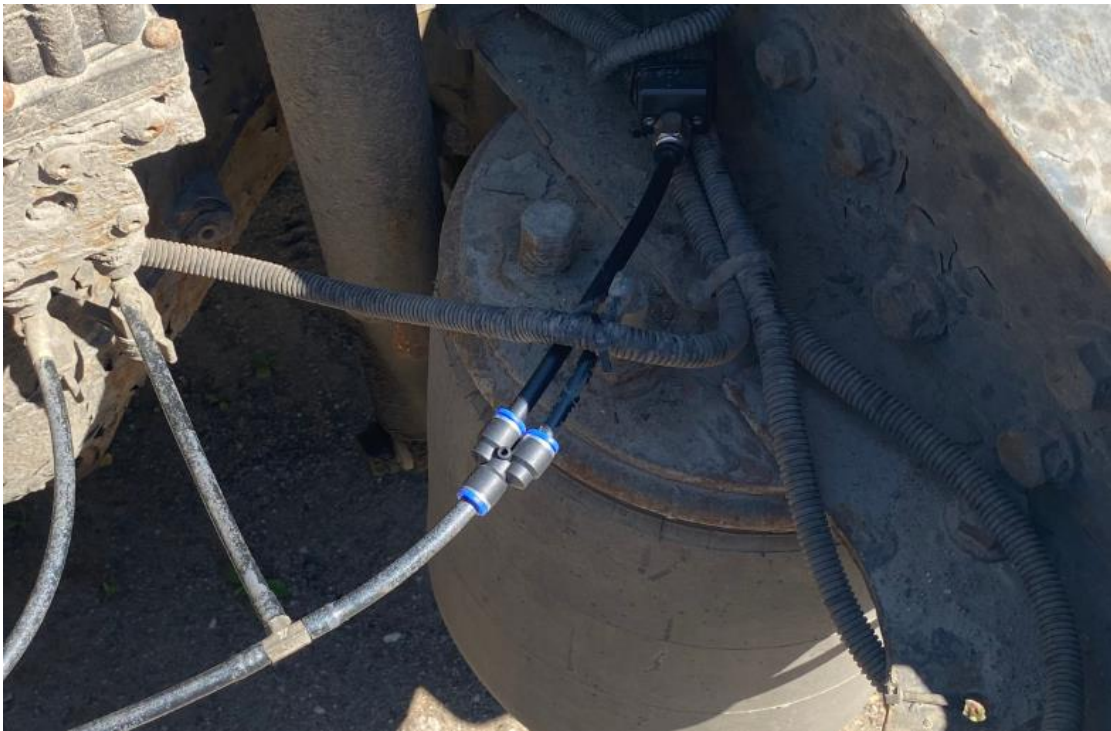
рис. 3.4. Подключение пневмомагистралей завершено
